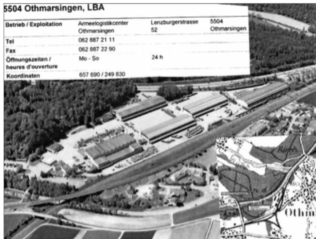
La base logistique de l'armée ne respecte aucune règle de la décentralisation tactique de l'équipement matériel de l'armée. Sur Internet, toutes les règles de discrétion sont violées. (photo mad)
