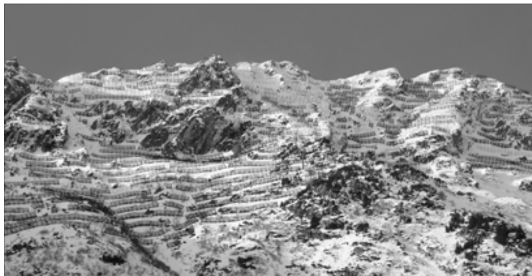
Œuvre du siècle. De nombreuses constructions de protection contre les avalanches protègent les hommes et les animaux. (photo thk)
