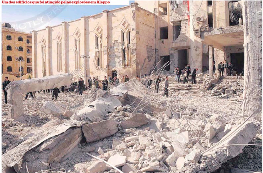
Um dos edifícios que foi atingido pelas explosões em Aleppo
